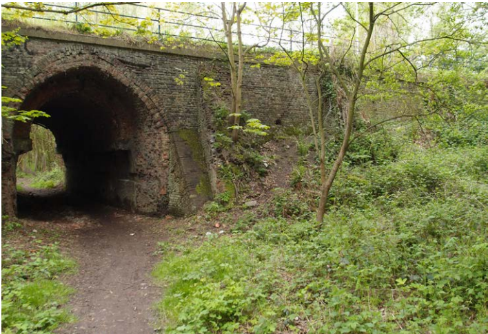
Bestaande onderdoorgang onder de Kapelstraat
